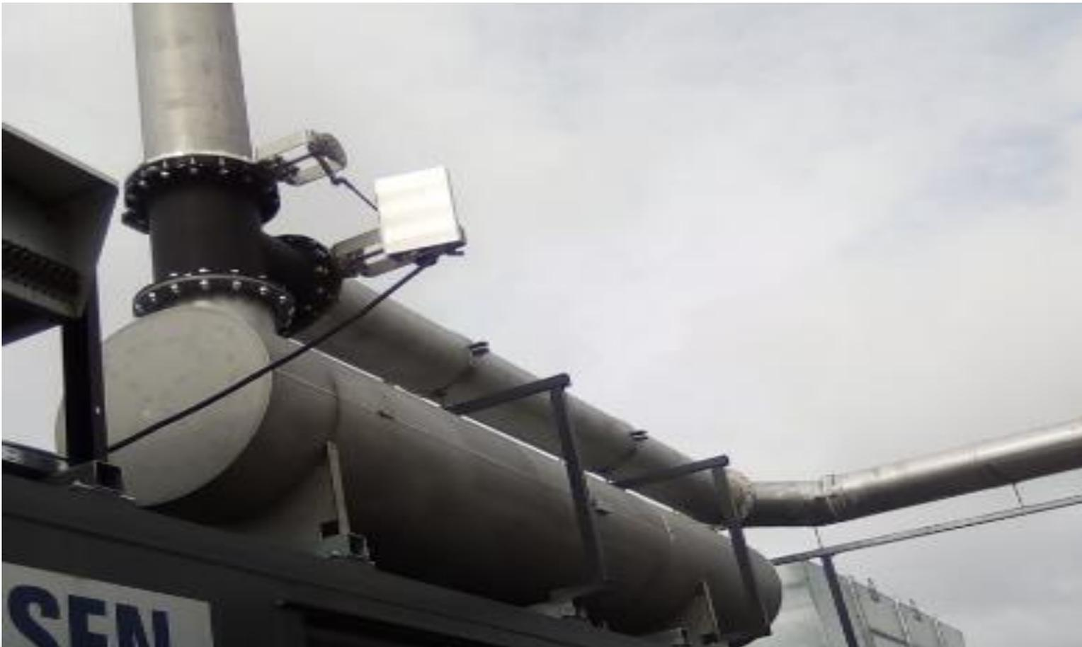
Der Anschluss des BHKW an die Nachbehandlungsanlage erfolgt mittels steuerbarer Klappen, die den Kamin in die gewünschte Öffnung (nach Oben bei Havarie) Horizontal –Zuleitung des Abgases zur Nachbehandlung und Nutzung
