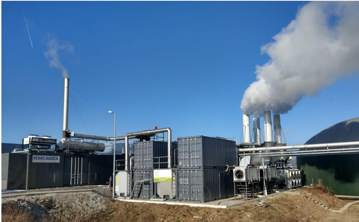
Aufkonzentrationsanlage zur Herstellung von Flüssigdünger
