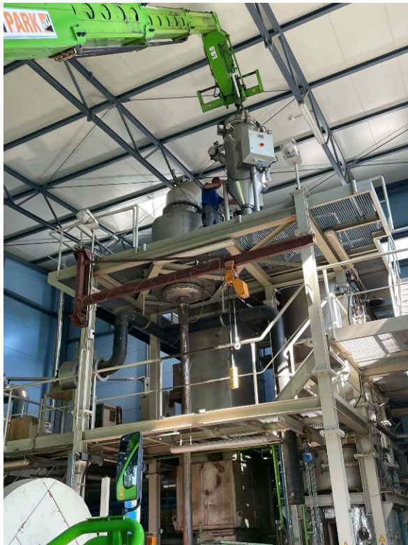
Abb. 16: Einbau Heißgasfilter
